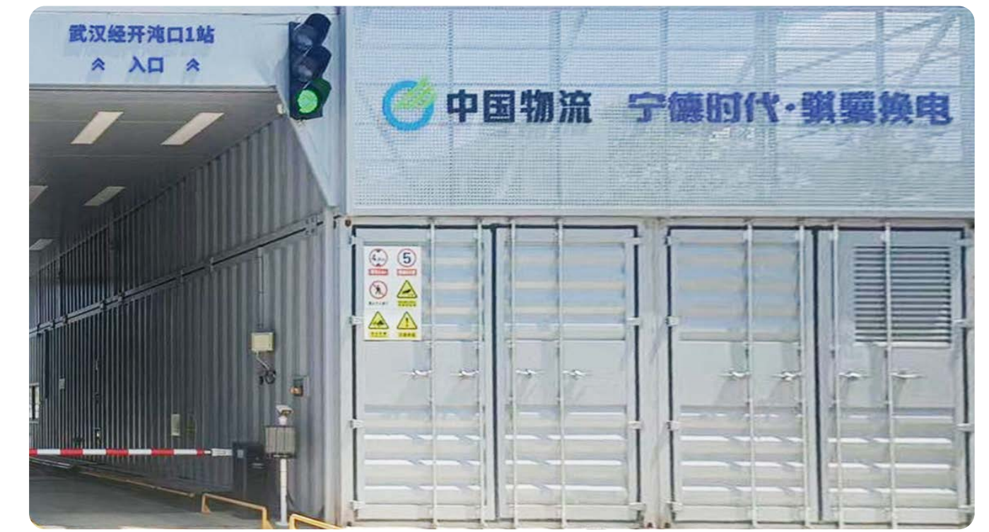
生產基地投建換電站
