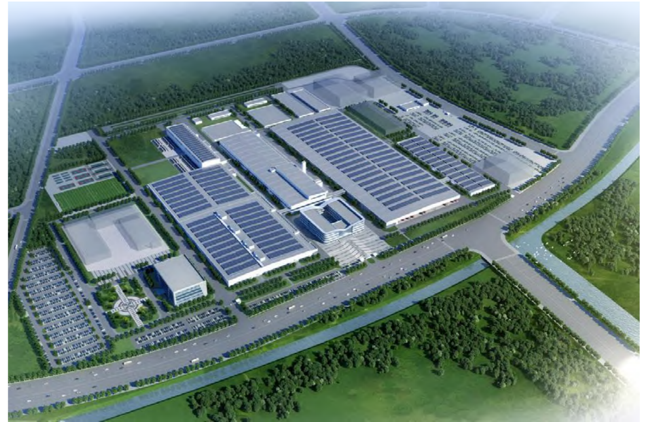
肇庆生产基地光伏车棚和屋面发电项目
