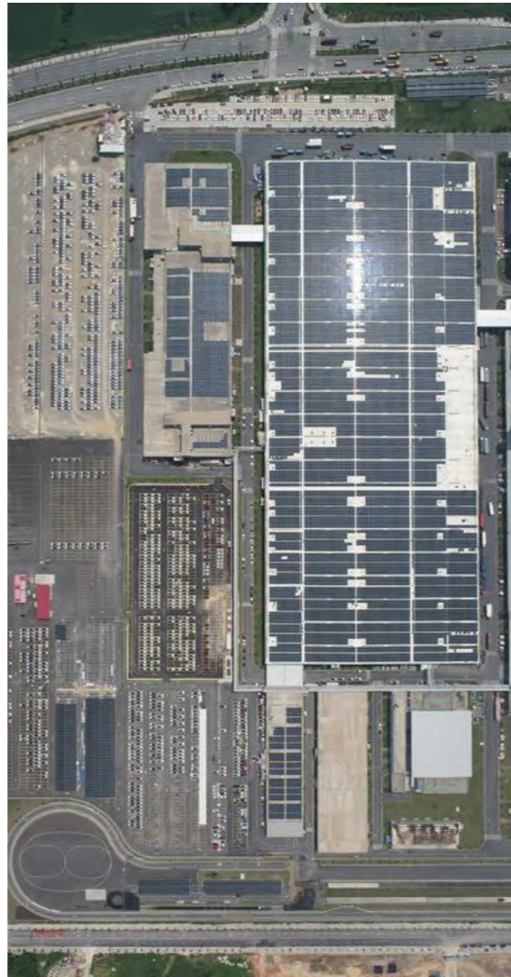
肇庆生产基地光伏车棚和屋面发电项目
